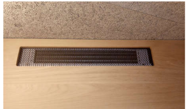
Luftauslas hinter Holzverkleidung
