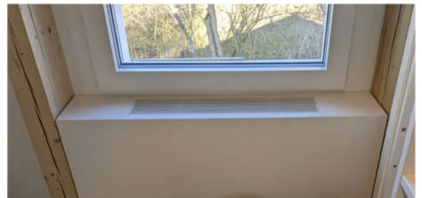
Einbau abgeschlossen, mit Blende
